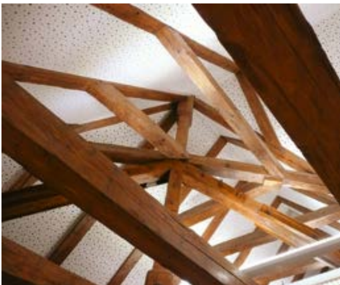
Beim großzügigen Ausbau des Dachgeschosses wurde auch das historische Dachgebälk freigelegt.
