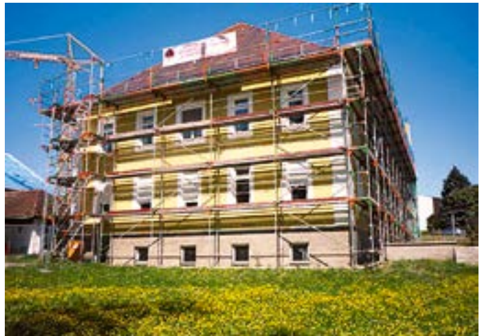
Wir bauen an der Zukunft: Derzeit wird die Fachakademie umgebaut. Die Räume werden so eingerichtet, dass eine zukunftsfähige Ausbildung möglich ist.
